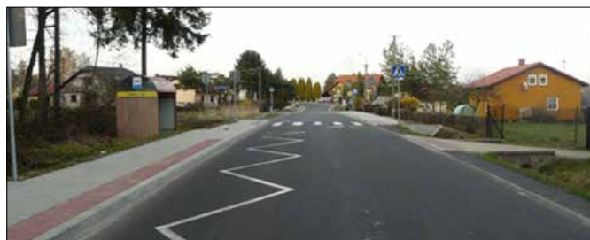
Przebudowa ul. Tuwima w Kaczycach i ul. Korczaka w Kończycach Małych
